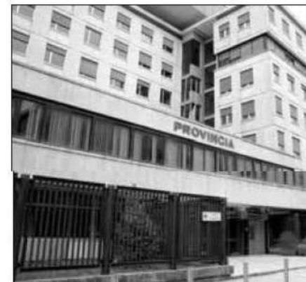
Il palazzo dell'amministrazione provinciale
